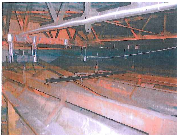
Zdjęcie nr 1 Widok konstrukcji stalowej dachu nad widownią
