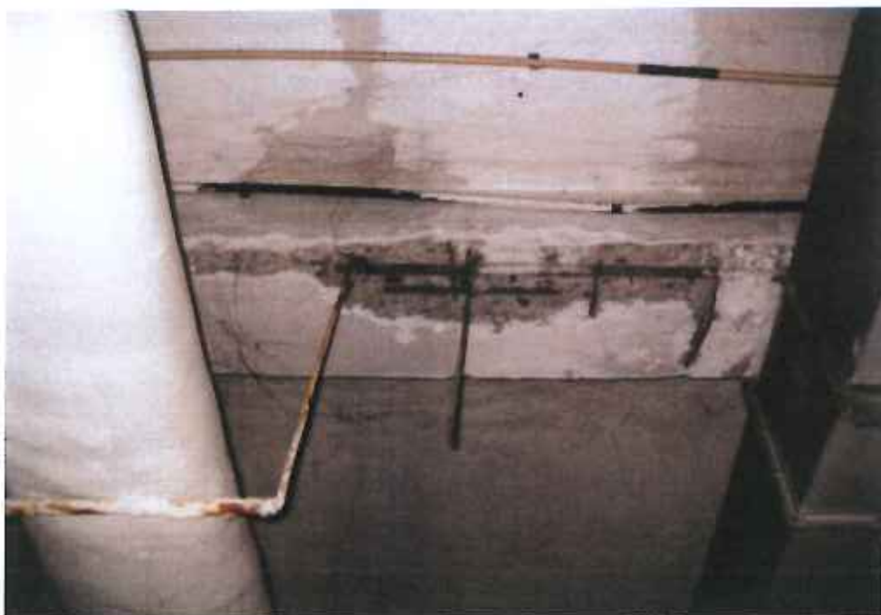
fot. 27 i 28. Rozkucia betonu kolejnych piwnicznego stropu nad pomieszczeniem wentylatorni w południowo – zachodniej części kondygnacji piwnicznej budynku
