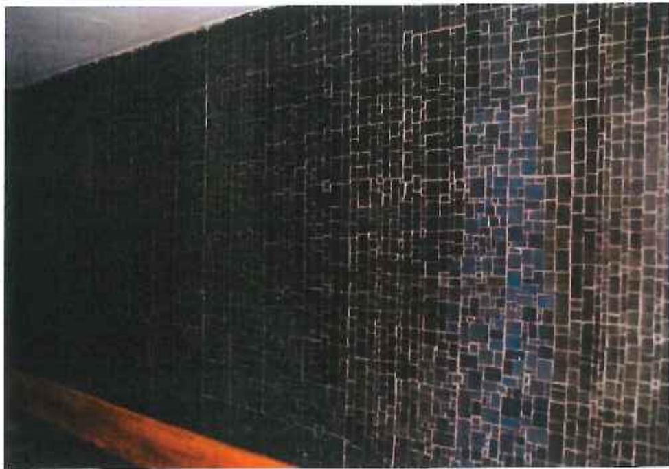
fot. 38. Ceramiczna okładzina na ścianie wewnętrznej przy biegu schodów wspornikowych łączących I i II piętro budynku
