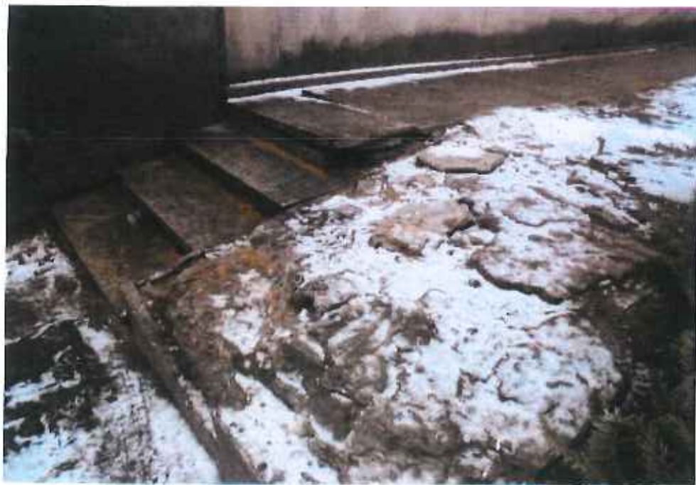
fot. 74. Rozpadające się schodki przy zachodniej elewacji budynku
