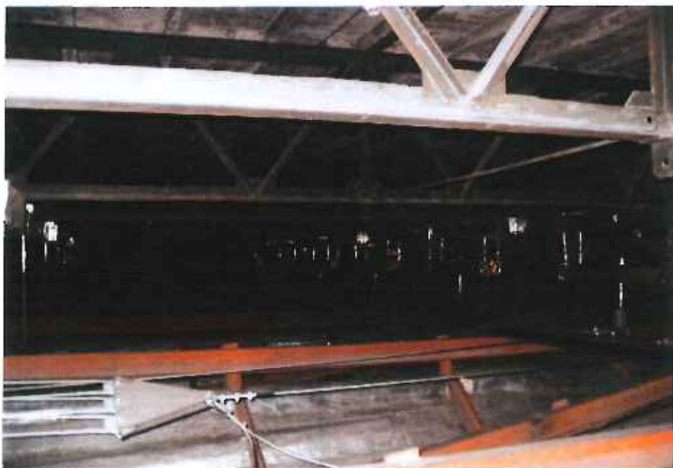
fot. 56. Fragmentu konstrukcji sufitu podwieszonego nad widownią
