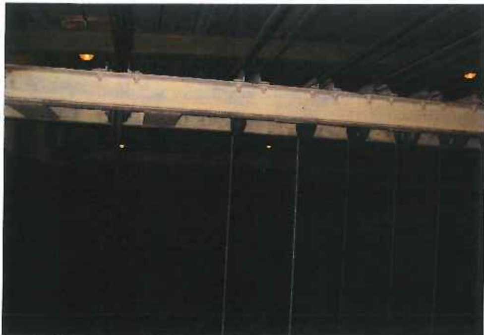
fot. 57. Widok fragmentu konstrukcji poddasza nad sceną teatru
