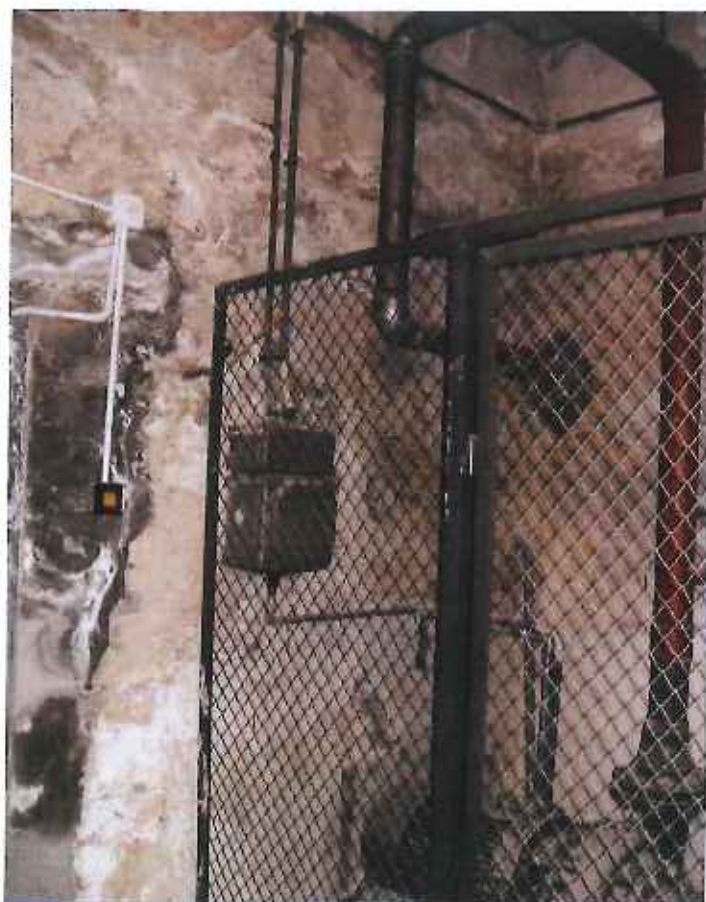
fot. 3. Mokra, z ogniskami zagrzybienia, ściana piwniczna skrajnego wschodniego pomieszczenia ciągu magazynów
