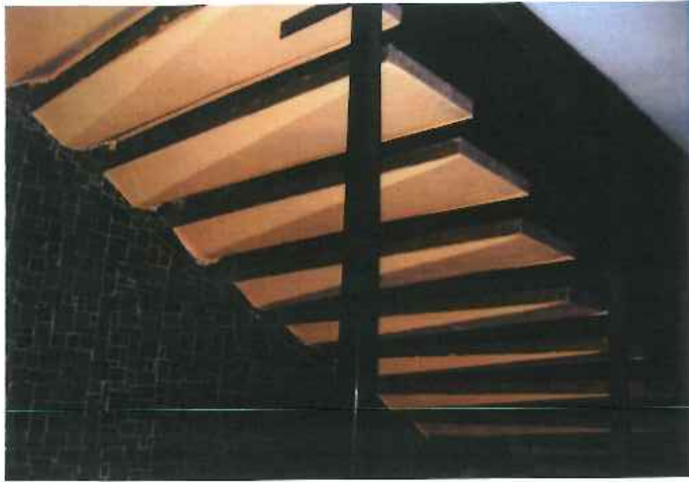
fot. 50. Bieg wspornikowych schodów łączących I i II piętro budynku
