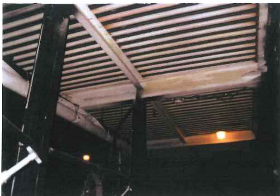
fot. 58. Widok fragmentu konstrukcji pomostów obsługowych nad sceną teatru
