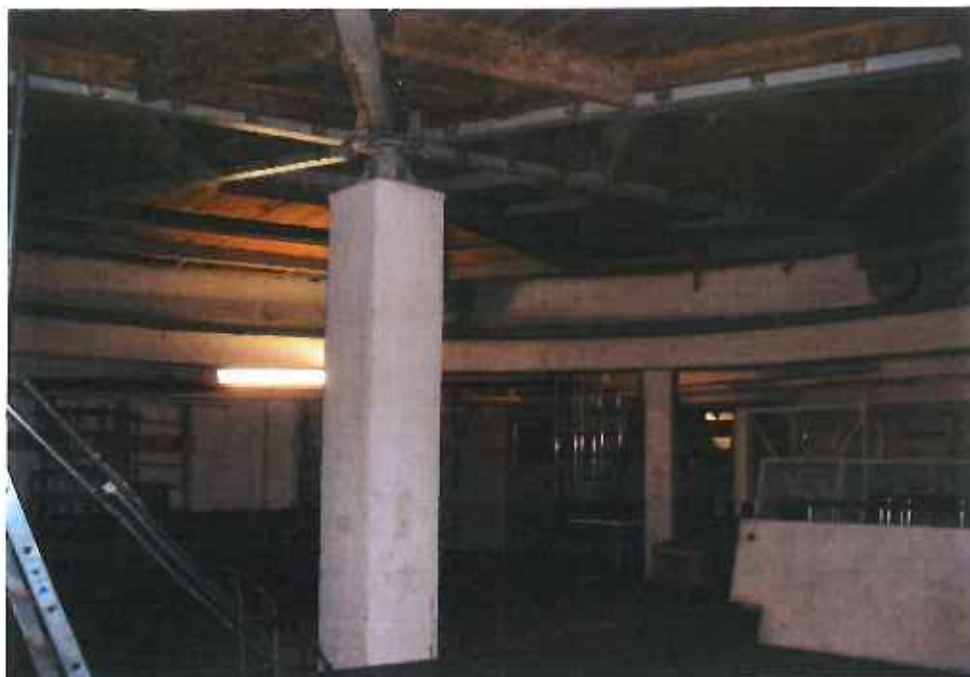
fot. 35. Widok ogólny pomieszczenia piwnicznego pod sceną teatru
