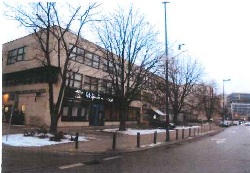
fot. 1. Widok ogólny południowej części budynku Teatru Żydowskiego od strony południowo-wschodniej
