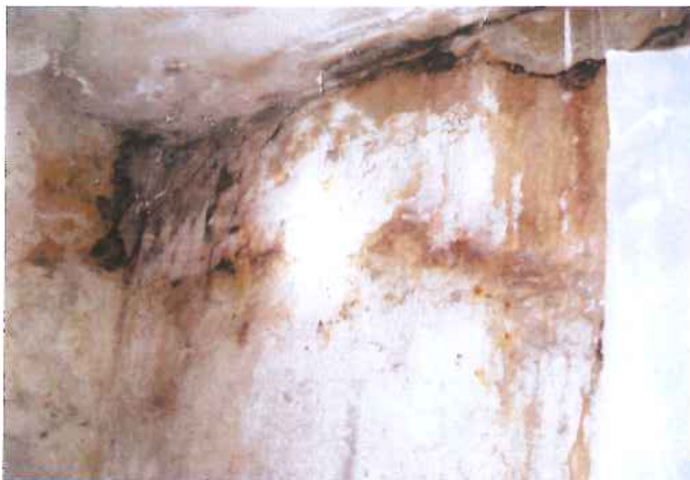
fot. 3. Mokra, z ogniskami zagrzybienia, ściana piwniczna skrajnego wschodniego pomieszczenia ciągu magazynów
